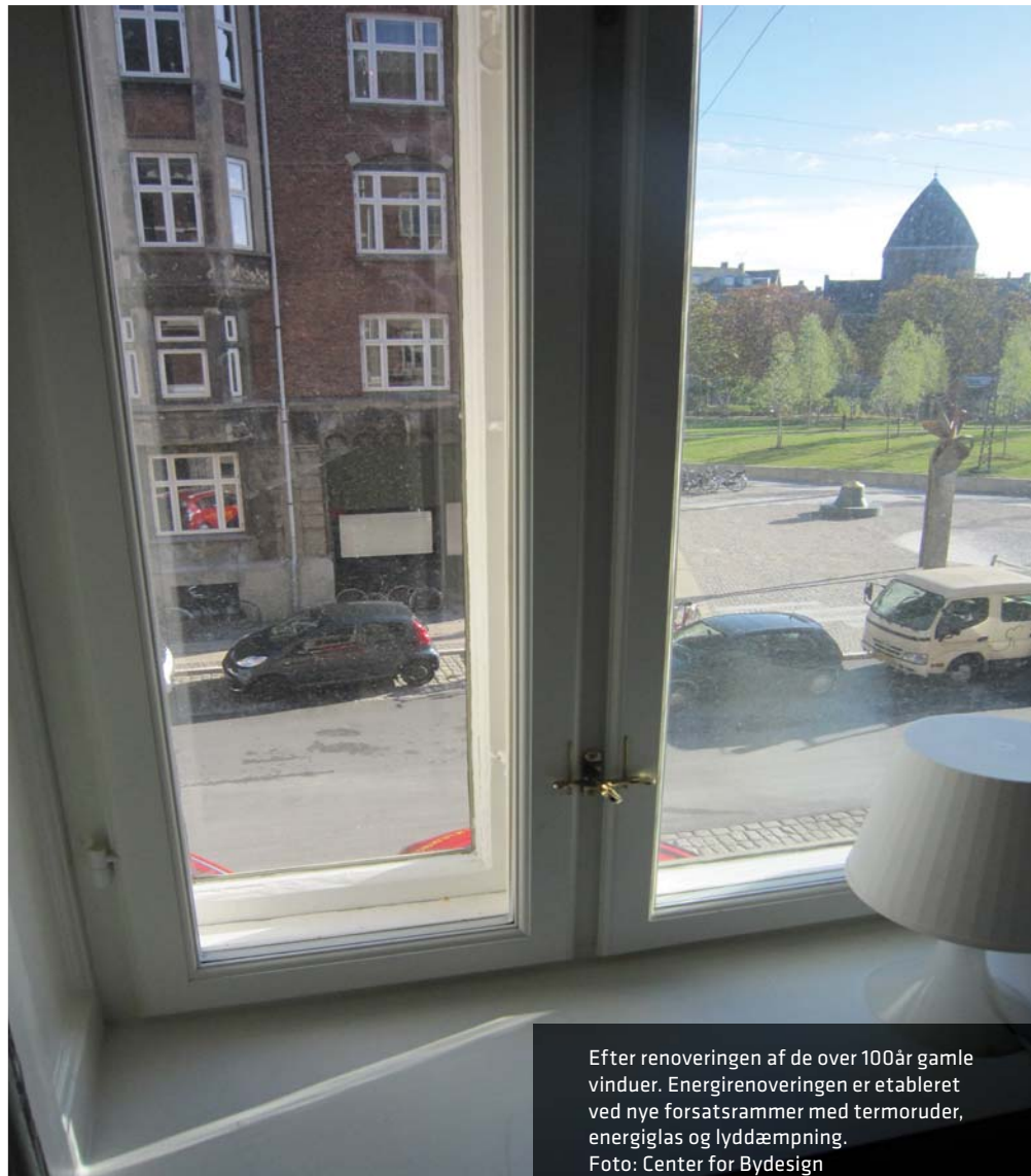
Vinduer under renovering. Vinduerne er bæredygtigt renoveret med linolie. Foto: Center for Bydesign
