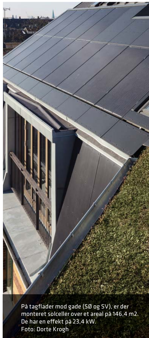
Tagterrasser og sedum-dækkede tagflader, ovenpå nye, bæredygtige taglejligheder, der erstatter en ubenyttet og nedslidt loftsetage. Foto: Bo Bjerre Hansen
