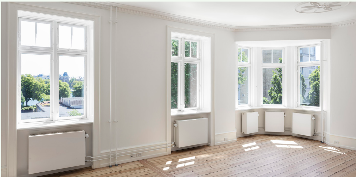
I Ryesgade 25 er der isoleret indvendigt for at bevare det udvendige facadeudtryk. Brystnings- og lysningspaneler er genskabt efter isolering.
