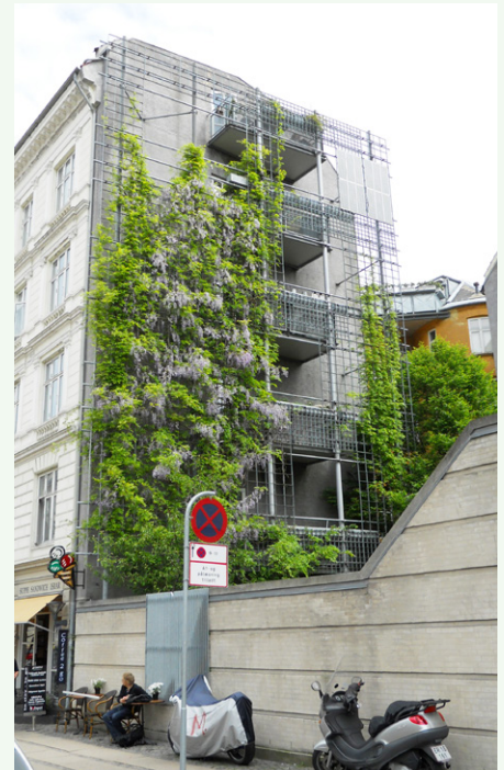
Gavlisolering og begrønning. Halmtorvet 1.
