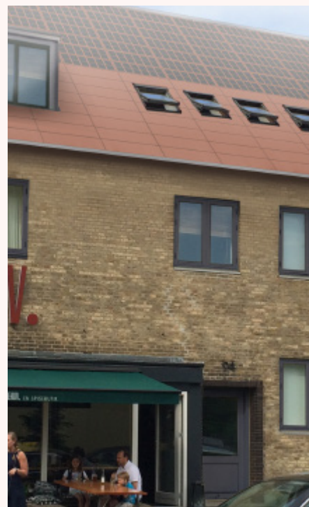
Røde bygningsintegrerede solceller på Rentermestervej 94.
